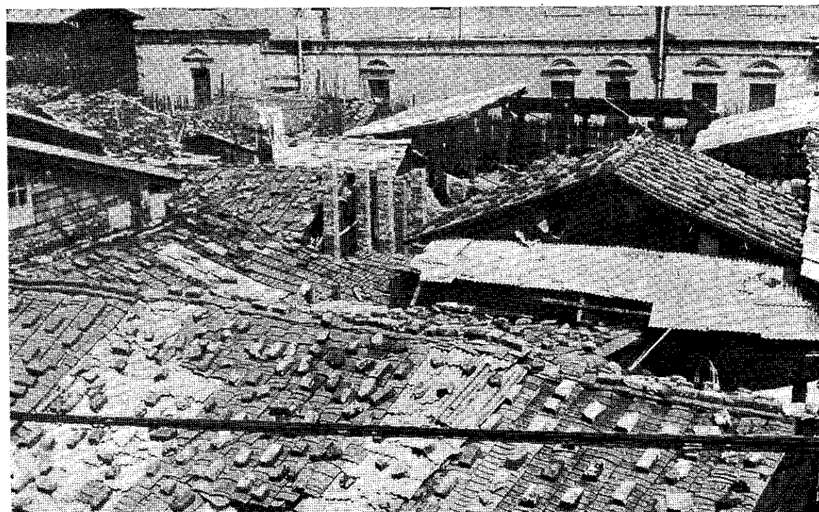
舊式的瓦可用石灰敷在屋頂木排上，或者也可鋪在屋頂，用磚壓着。
